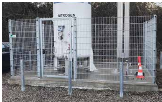
Galvaniseret panelhegn med faste pullerter.
