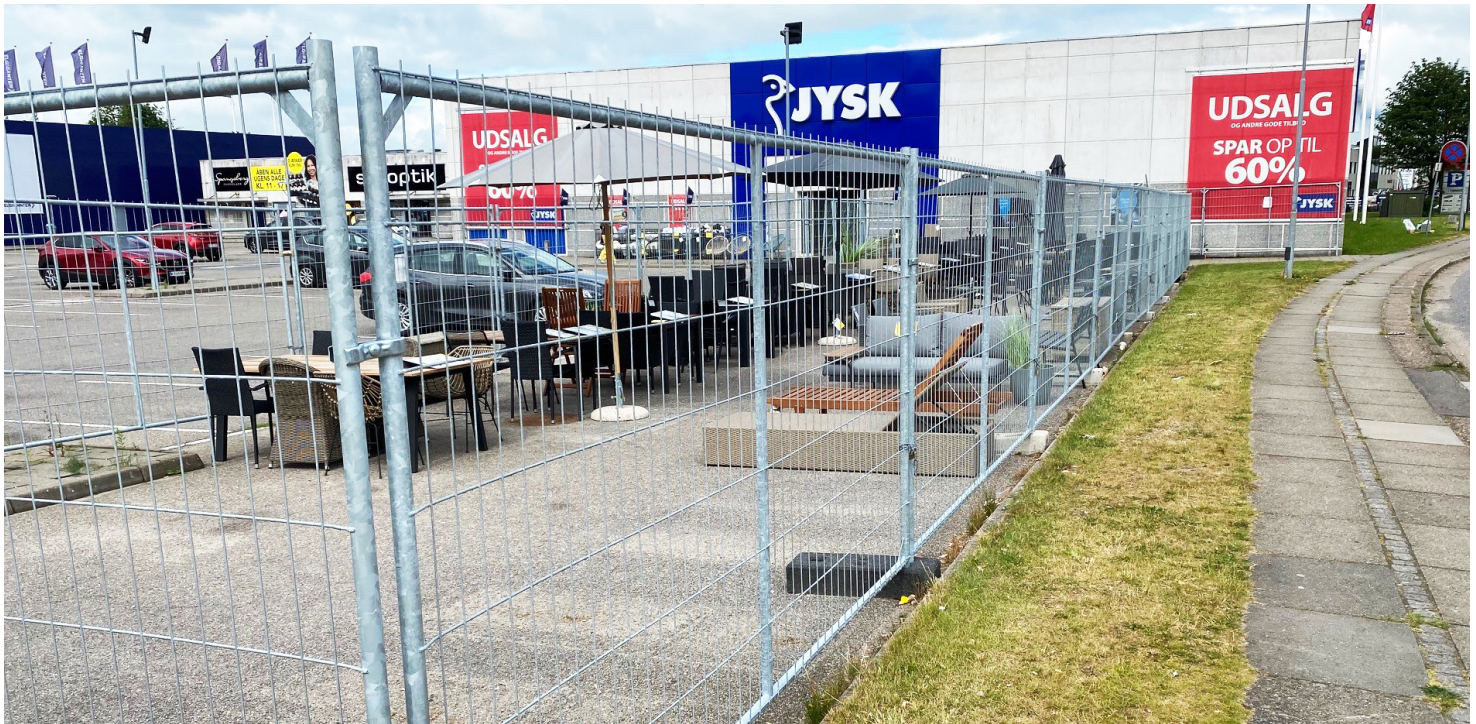
Byggepladshegn til beskyttelse af udendørs varesalg
