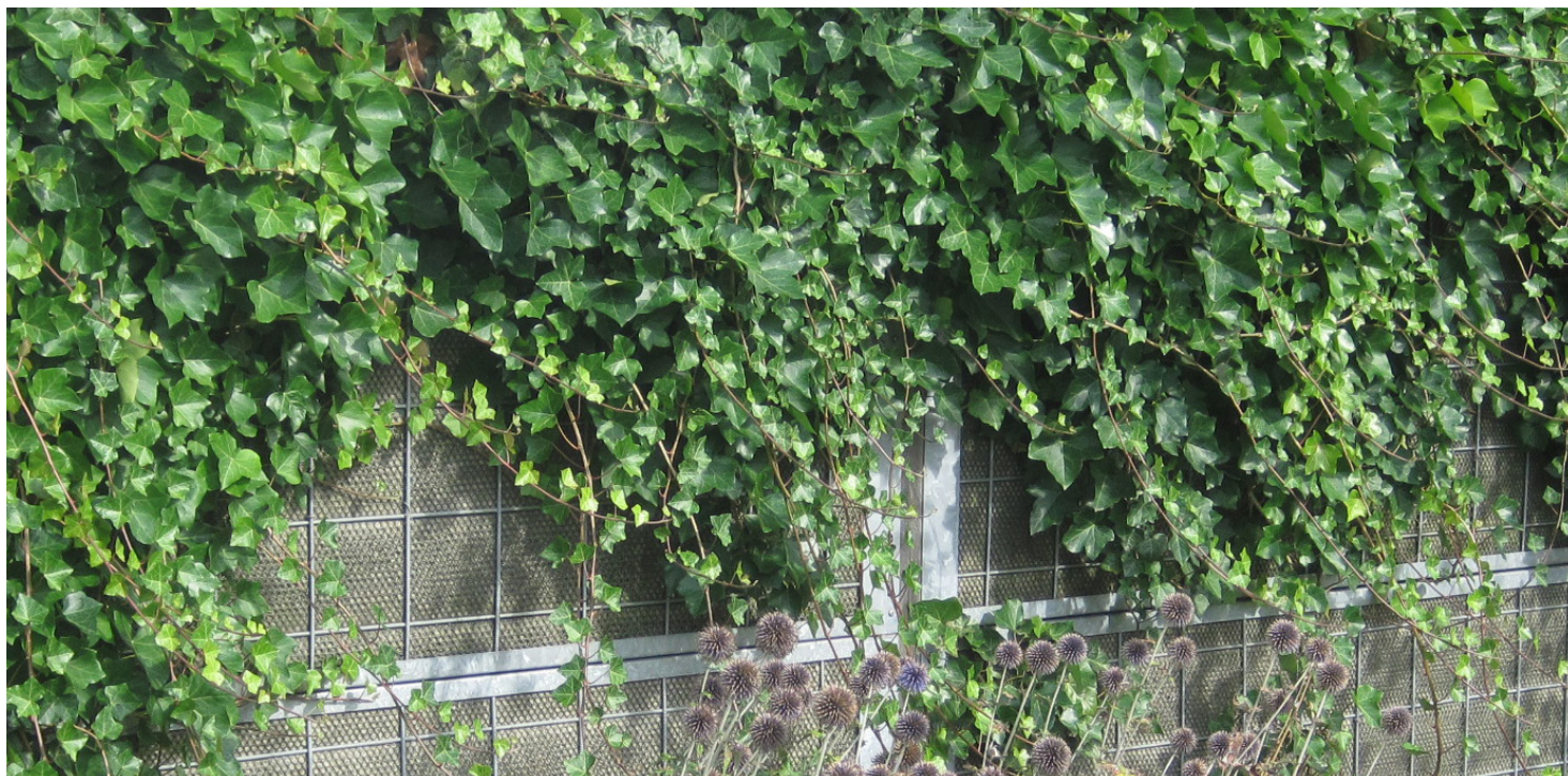
Det solide støjhegn kan beklædes med grønne planter og fremstå som et mere naturligt element
